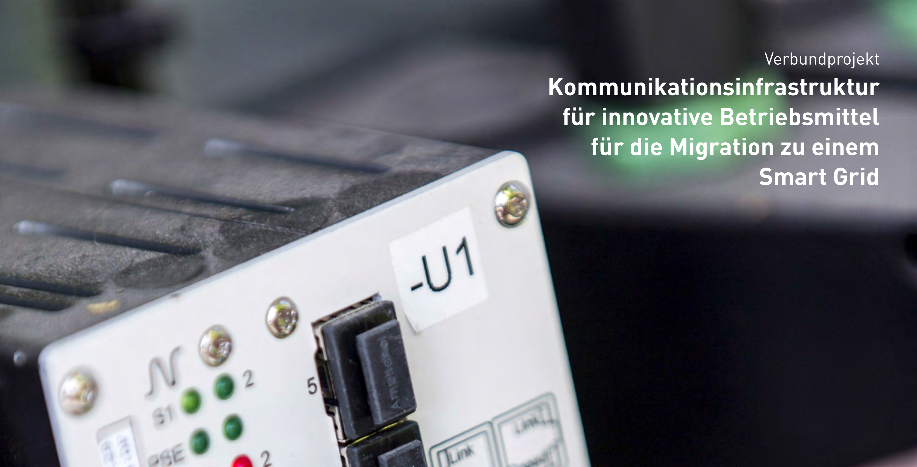
Abbildung 39: Nexans Switch, Roder Weg (Aachen West)
