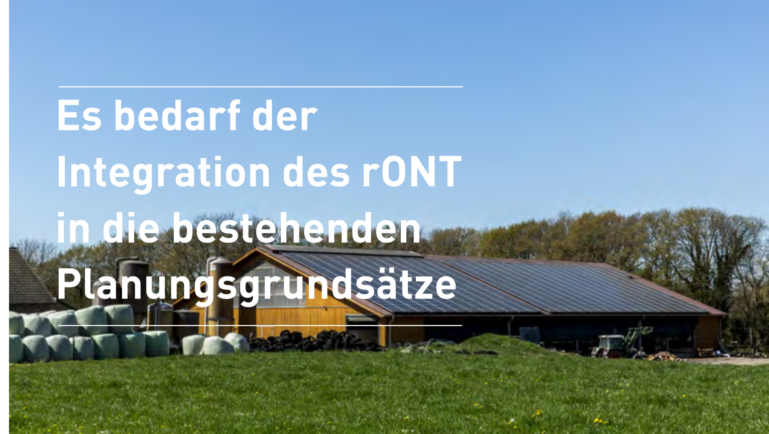
Abbildung 38: Bauernhof mit PV-Anlage, Pannekogweg (Aachen)
