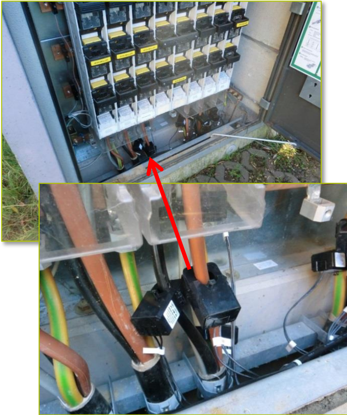
Strommessung Abgänge Netzstation (Bildquelle: MR)
